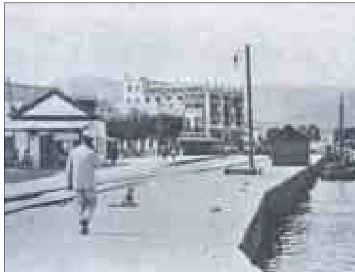
Algeciras 1913. Muelle de Madera construido en la parte sur del Río de la Miel
