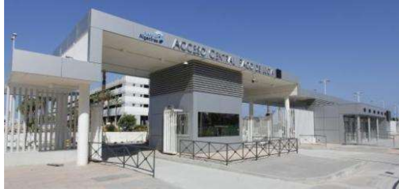
Ilustración 23 Acceso dársena central del puerto
