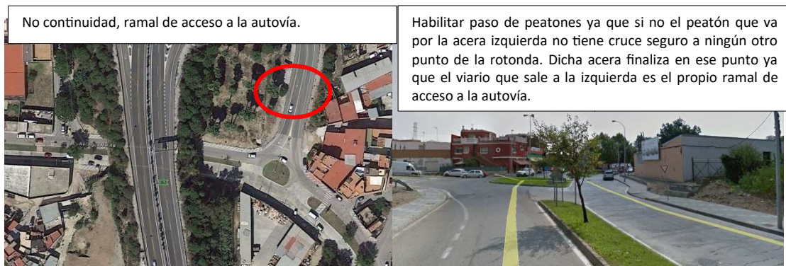
Rotonda este del nudo de la Avda. Agua Marina bajo el eje de la Autovía A-7
