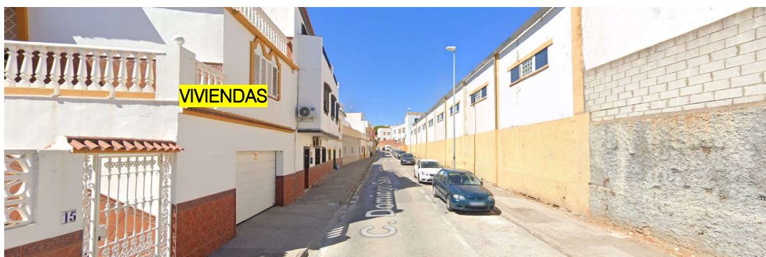
Figura 4.- Vista de la calle Domingo Salvo
