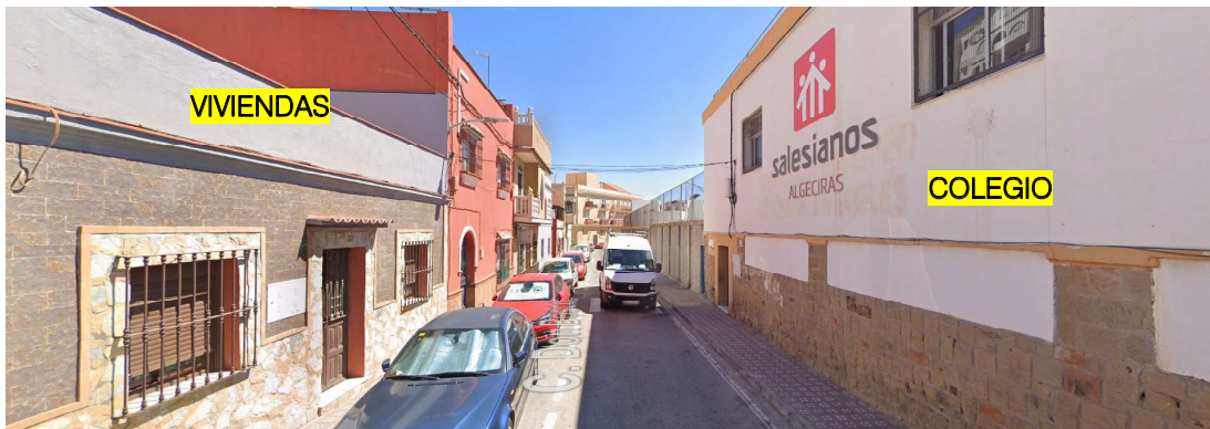
Figura 7.- Vista de la calle Don Bosco
